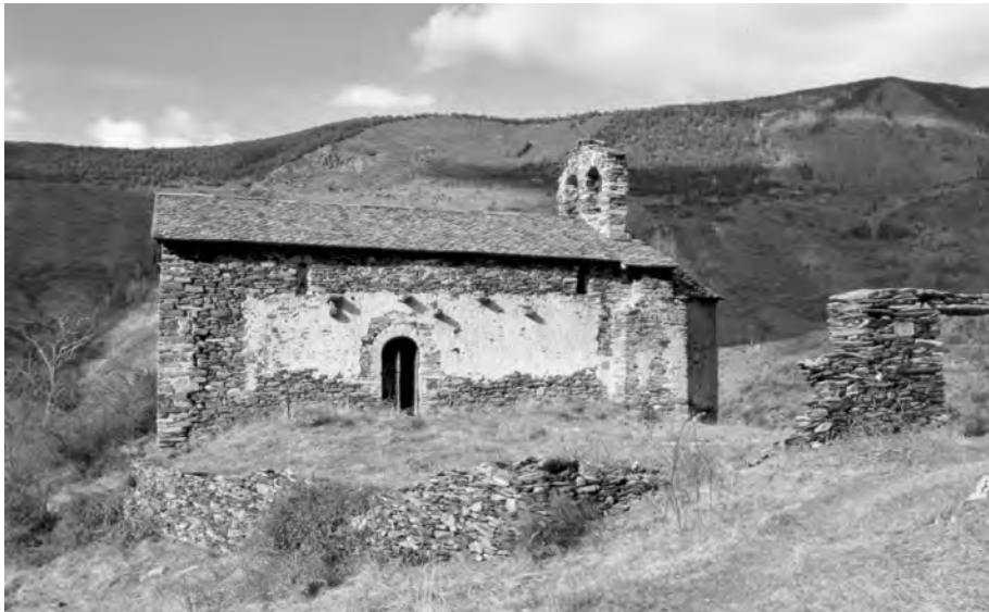
FIGURA 33. Santa Eulàlia d'Alendo. Vista del conjunt de l'església des del sud. (Clixé: Aida Mestres)
