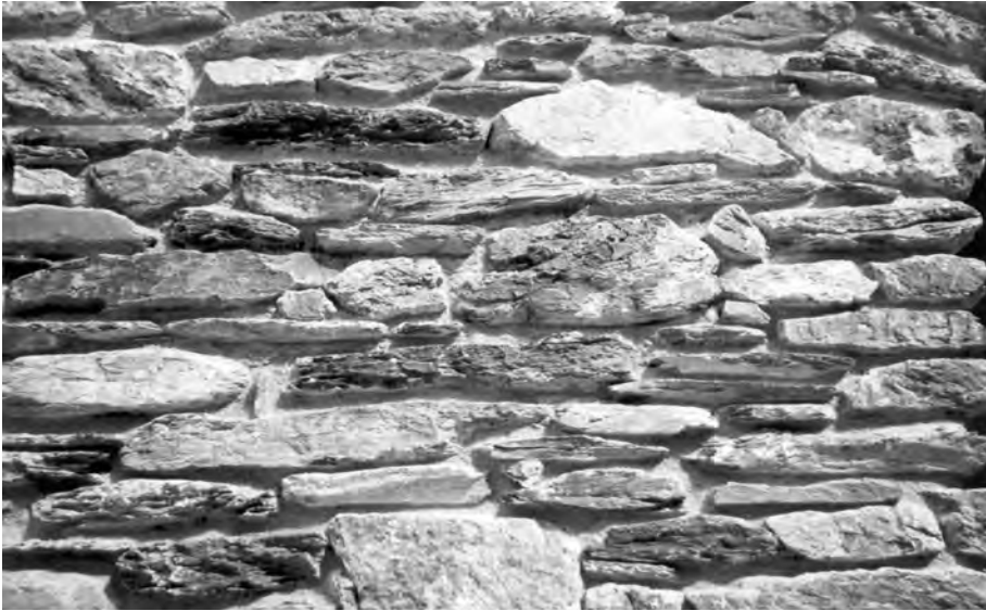
FIGURA 29. Sant Esteve d'Araós. Detall del parament. (Clixé: Brígida Montero i Lavínia Herrera)
